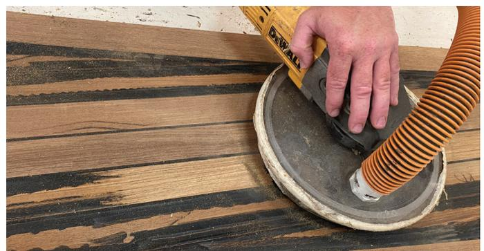
15. Lassen Sie die Fugenmasse mindestens 48 Stunden aushärten (bei kaltem Wetter und bei größeren Fugen noch länger). Weißes und graues Dichtmittel sollte mindestens 12 Tage vollständig aushärten. Weitere Einzelheiten finden Sie im Abschnitt "Weiße und graue Abdichtungen". Nach dem Aushärten kann überschüssige Dichtungsmasse mit einem dafür geeignetem Fein Werkzeug oder einem scharfen Stechbeitel entfernt werden.
