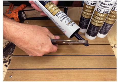
12. Schneiden Sie die Spitze mit einer Rasierklinge in einem leichten Winkel ab. Beutel oder Kartusche in die Pistole einsetzen.
