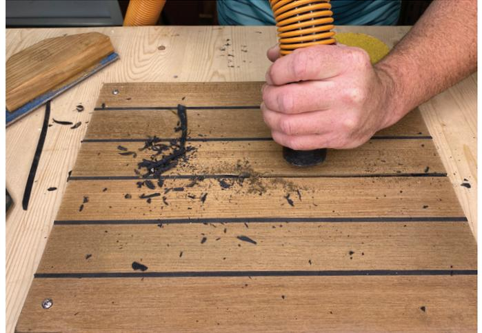
8. Im Vorfeld des Entfettens sollten die Staubpartikel noch mit Staubsauger oder Druckluft entfernt werden.
