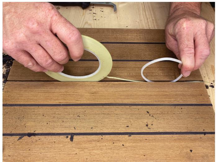
11. KEINE GRUNDIERUNG VERWENDEN. Um beste Ergebnisse zu erzielen, sollte vor dem Verfugen ein Klebeband auf der Unterseite einer 5 mm oder tieferen Naht angebracht werden. Es verhindert ein Anhaften an der Unterseite der Fuge. Eine zweite Rolle Klebeband oder der Rollenkern kann verwendet werden, um das Klebeband in die Fuge einzubringen.
