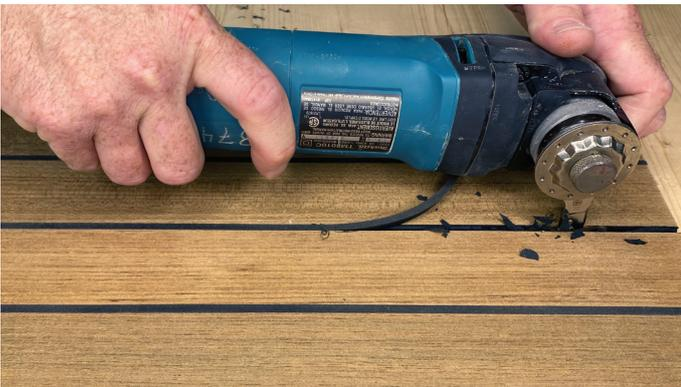
3. Andere präzisere Elektrowerkzeuge können verwendet werden, um die alte Verfugung auszuschneiden und in einigen Fällen die Fugen zu vertiefen.
