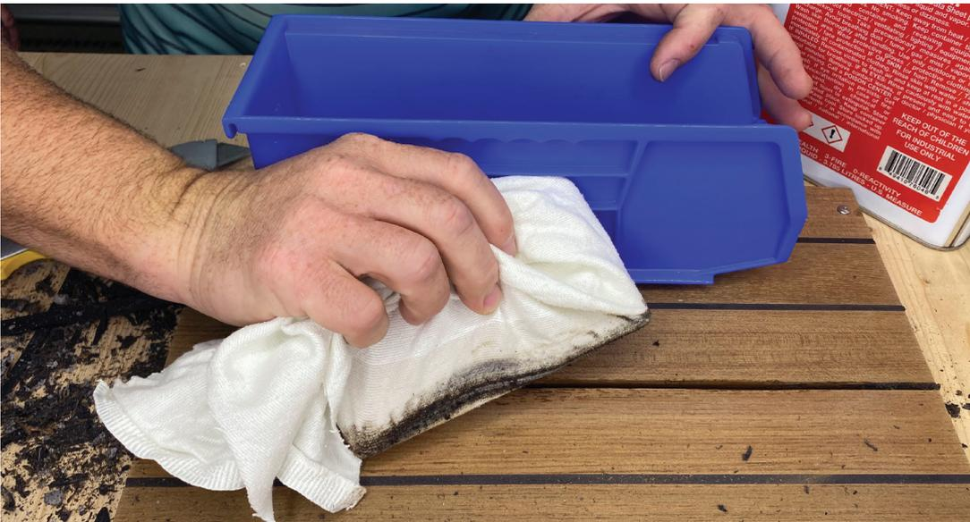
9. Reinigen und entfetten Sie die Fugen mit einem in ein sauberes Tuch gewickeltem Spachtelmesser oder einem anderen flachen Stück. Das Tuch mit Aceton anfeuchten und häufig wechseln. Mit vorwärts- und Rückwärtsbewegungen die Fuge reinigen. Das Aceton trocknen lassen und dann sofort nach dem Anbringen eines bindungstrennendem Klebebandes (z.B. 3M Fine Line Tape #218) verfugen.
