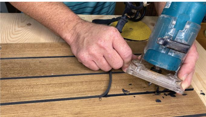
5. Bei größeren Nachfugprojekten kann eine Kreissäge oder Oberfräse verwendet werden, um sauberes und frisches Holz an den Seiten der Fuge zu erhalten.
