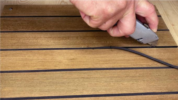
1. Altes oder beschädigtes Fugenmaterial kann mit einer scharfen Rasierklinge entfernt werden, wobei darauf zu achten ist, dass die Holzfaser nicht beschädigt wird.
